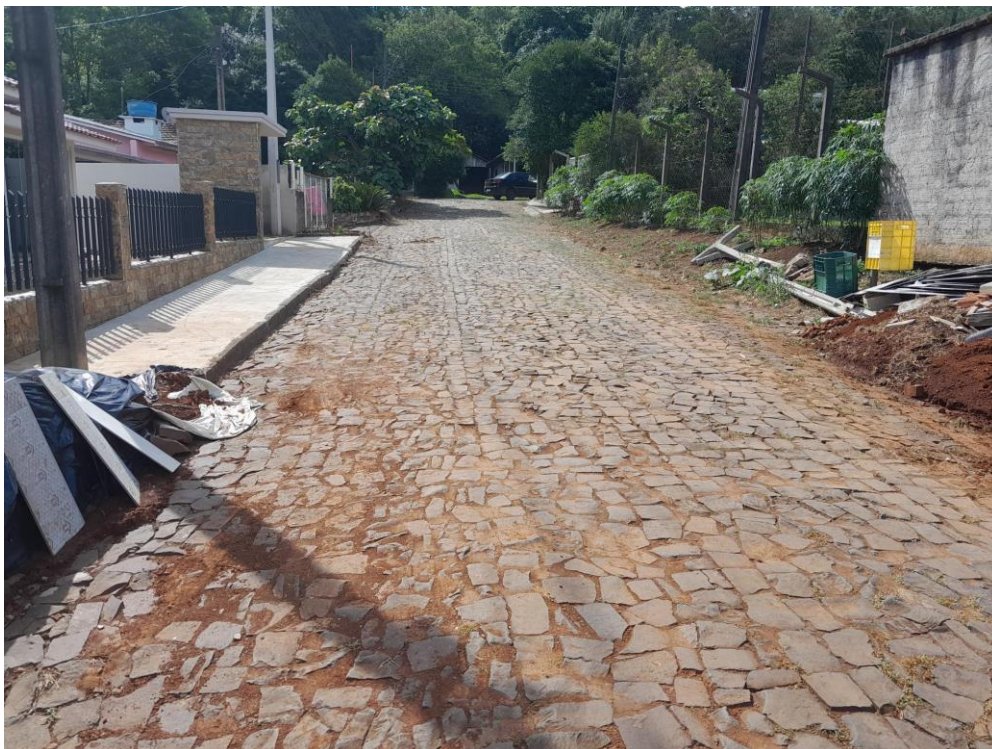
Vista pavimento rua Vitório Piccoli
