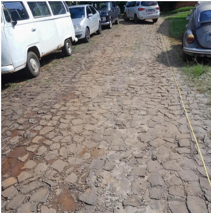
Detalhe pavimento rua Vitório Piccoli
