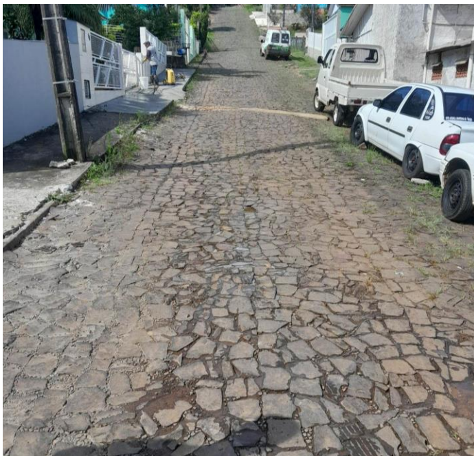
Vista pavimento rua Vitório Piccoli
