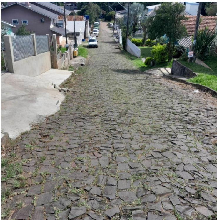
Vista pavimento rua Vitório Piccoli
