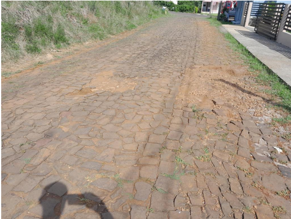
Detalhe pavimento rua Vitório Piccoli
