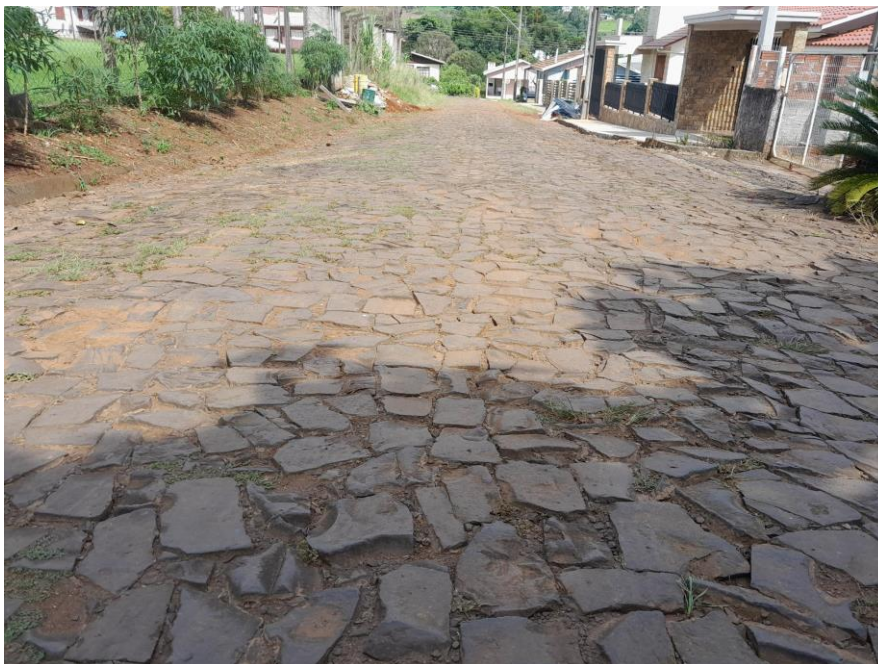
Detalhe pavimento rua Paulino Buratti
